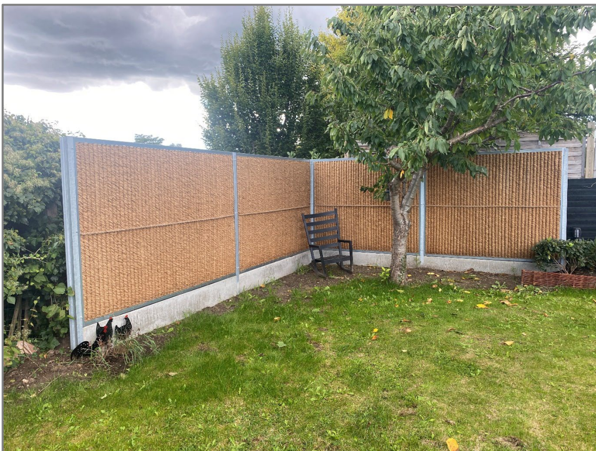
Figur 6-3. Hjørnet af haven på Oktobervej 121 efter opsætning af det lokale støjhegn.
