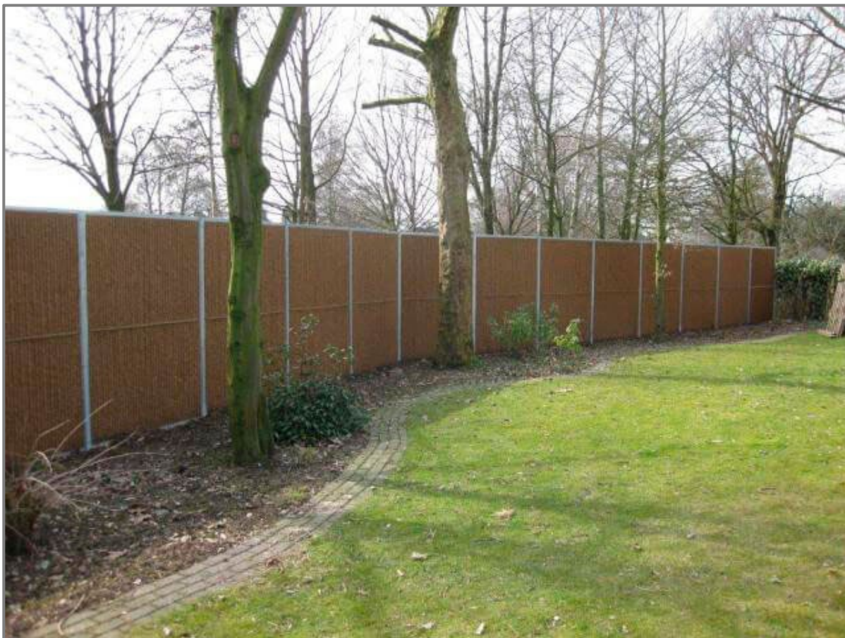
Figur 6-13. Eksempel på opstilling af det anvendte støjhegn fra Ishøj Hegn (Type 952). Kilde: Ishøj Hegn A/S. Opstillingen stammer ikke fra Rolig Have 2.0.
