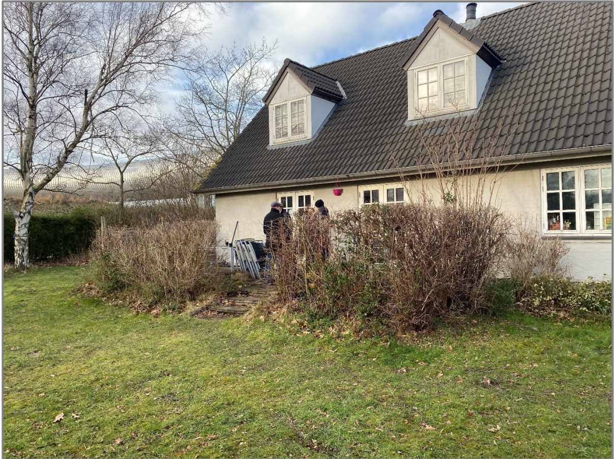
Figur 6-8. Terrassen ved huset på Munkevangen 15 inden opsætning af det lokale støjhegn.
