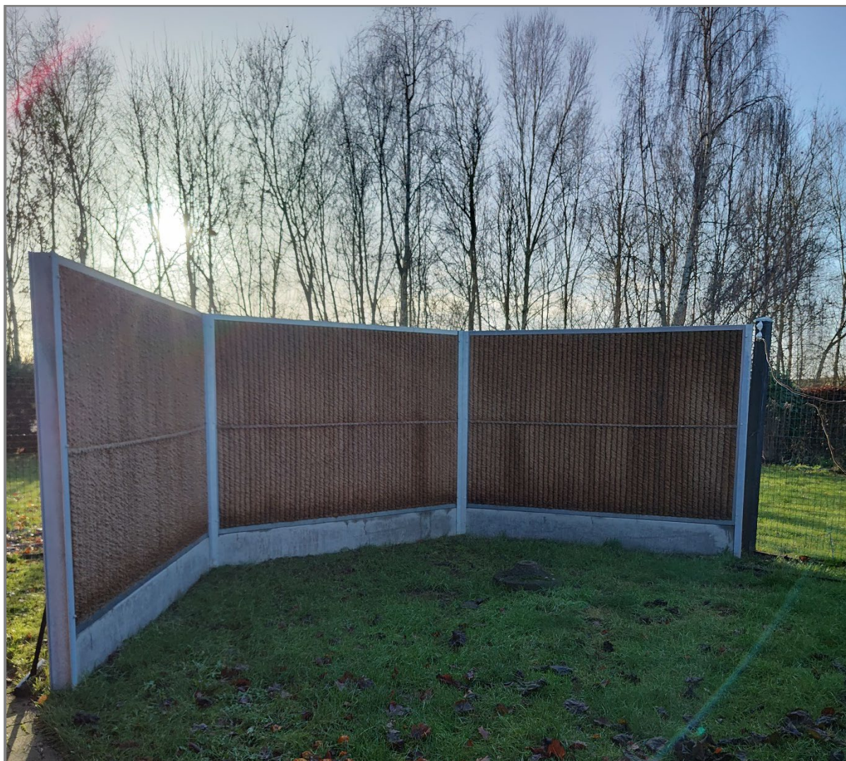
Figur 6-12. Det lokale støjhegn set fra terrassen efter opsætning ved huset på Bjæverskovvej 1A.
