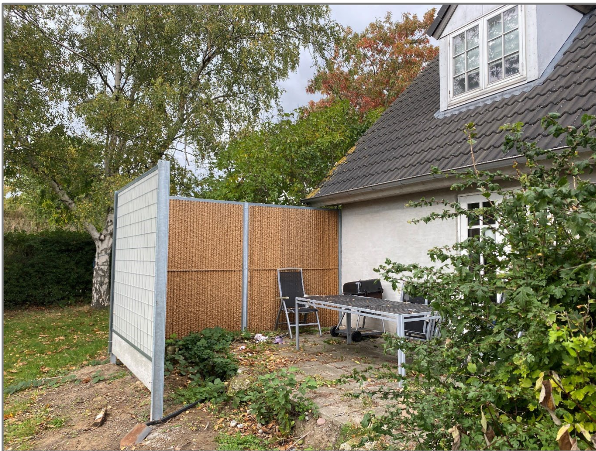
Figur 6-9. Terrassen ved huset på Munkevangen 15 efter opsætning af det lokale støjhegn.
