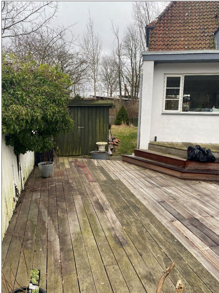
Figur 6-5. Billede af området ved støjhegnet på Skovdiget 12, set fra nordvest før opsætning.
