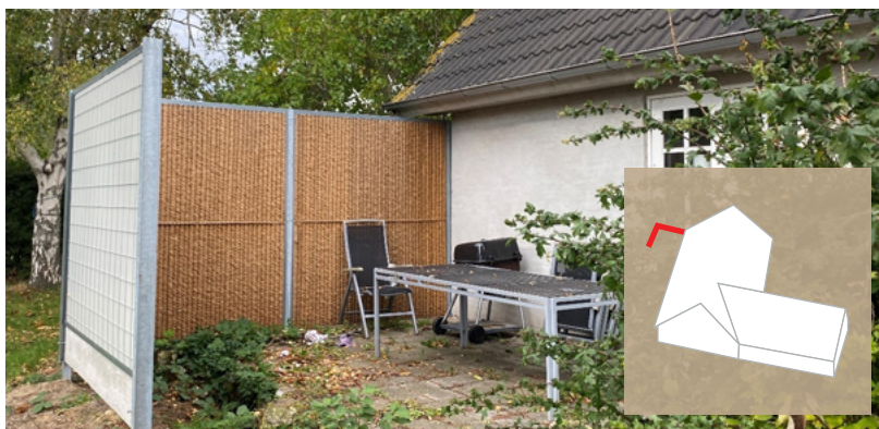
Sammen med en eksisterende mur kan støjhegnet danne en krog med 2 eller tre sider, hvor støjen er dæmpet.
