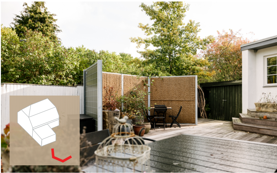
Et støjhegn med tre sider kan effektivt dæmpe for støjen, hvis den kommer fra mange retninger – for eksempel hvis en motorvej løber lige forbi haven.
